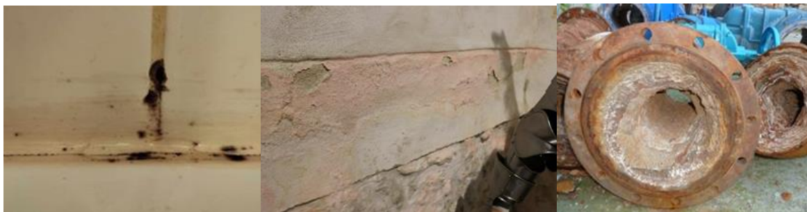
45. kép. Fekete penész fürdőszoba fugájában, baktériumok szaporodása falfelületen és csővezeték biodeteriorációja (Fotó: Makk Judit, Tóth Erika)
